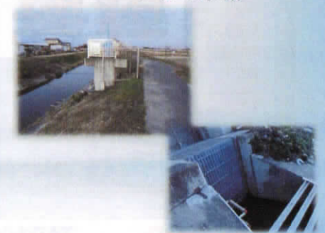
御陣場川と元小山川をつなぐ水路
